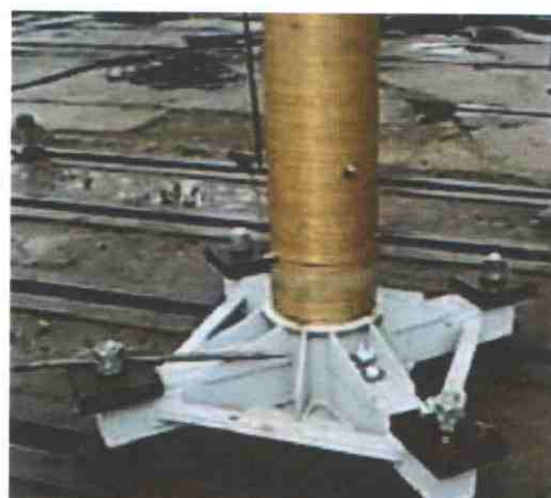
Переходник с установленной опорой
