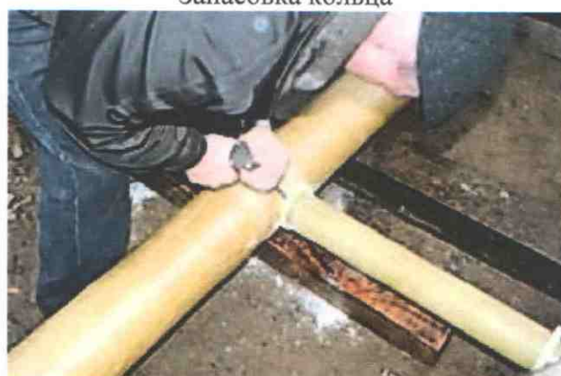
Сверление отверстия закрепления траверсы со стойкой
