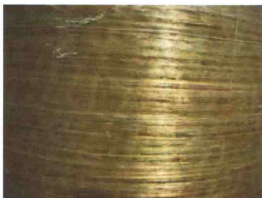
Горизонтальные трещины после разгрузки
