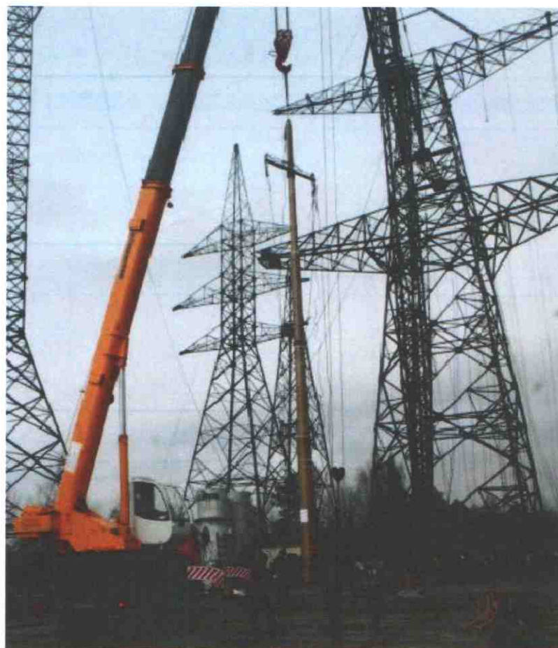
Рисунок 4 - Подъем стеклопластиковой промежуточной опоры автокраном
